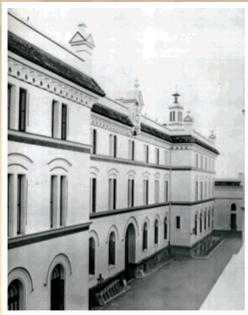
Fachada interior del bloque de Servicios.
